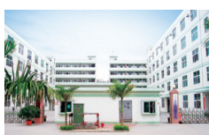
Завод в г.Сямынь
