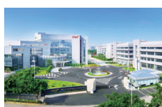
Завод в г.Сямынь
